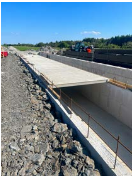
Fjøset får kanalørøring. Marius Dybing fra Fjøs-systemer, som var på byggeplassen da Buskap kom, advarer mot å bygge for brede kanaler. De bør ikke være bredere enn 1,5 meter.
