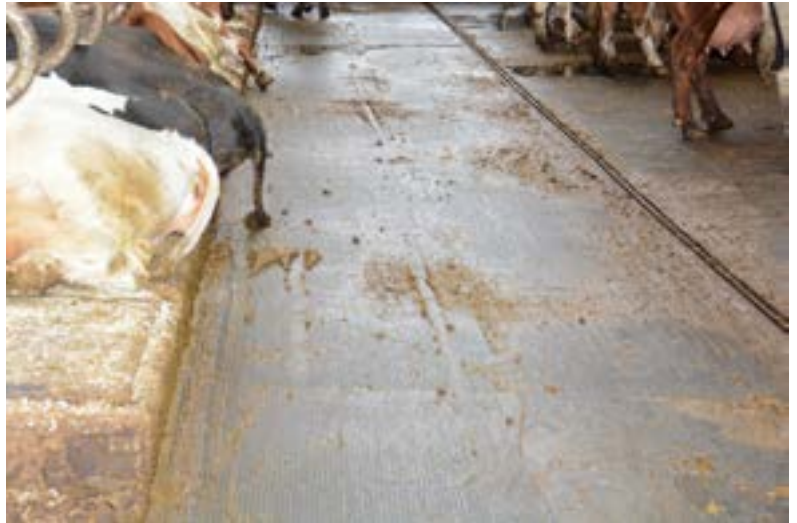
Gummiunderlag i gangarealet er bedre for klauvhelsen enn betong fordi mjukt underlag gir mindre belastningsskader på klauva. Foto: Rasmus Lang-Ree
