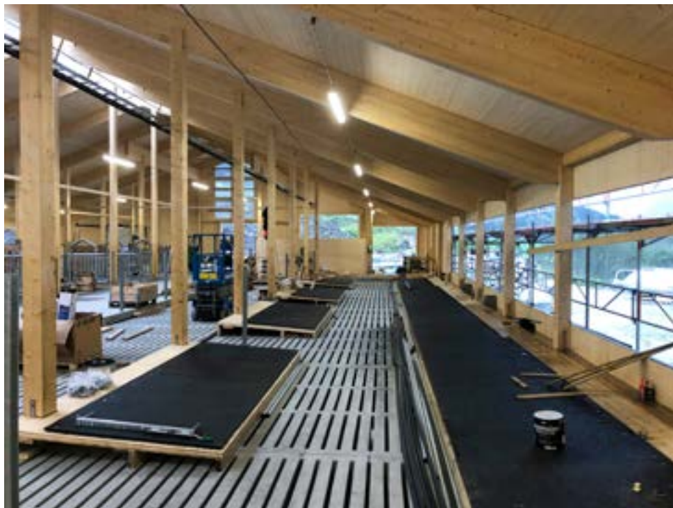
Innreiing av husdyrrommet, her frå ungdomsbygningane med liggebåsar. Arealet kan ominnreiest til liggepall, fullspalt til oksar, eller båsar til sinkyr.
