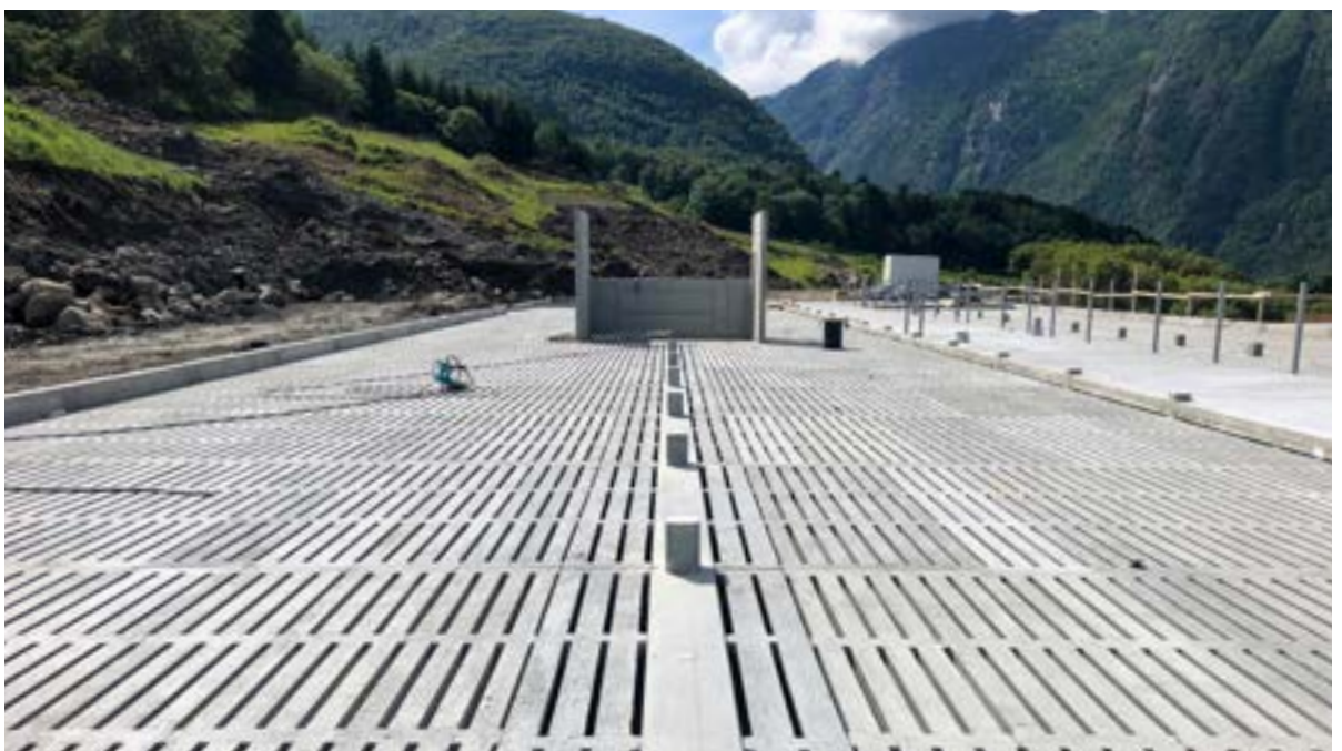
Eit "blankt ark", her er kun førbrett og robotgrav støypt. Men også roboten kan stå på spalt.
