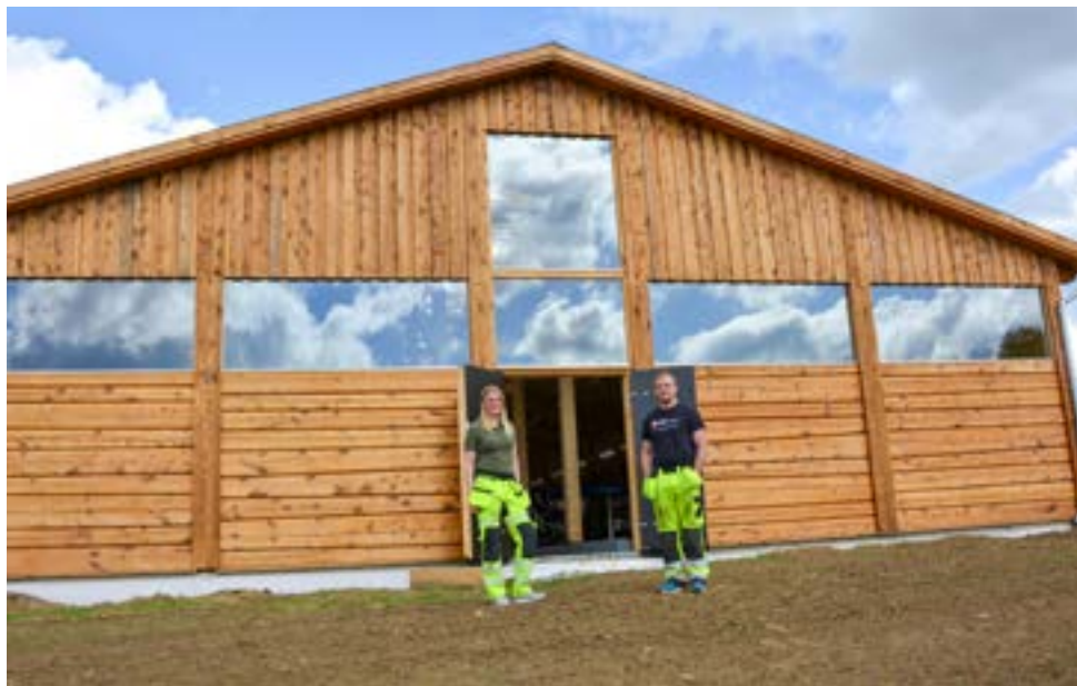
Store flater med vinduer slipper lys inn og gir utsikt.
